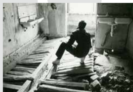
Holzbalkensanierung in der Schokofabrik. Foto: Elisabeth Rodé
